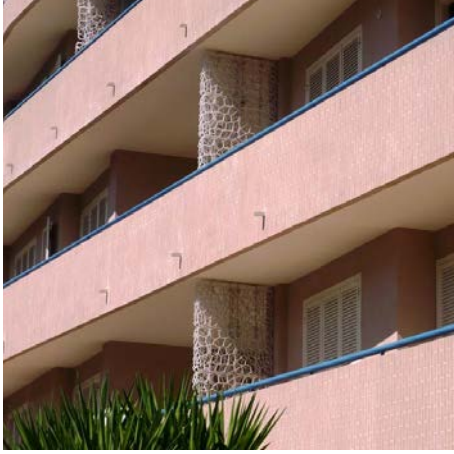
Şek.1 Bina dış görünüşü
