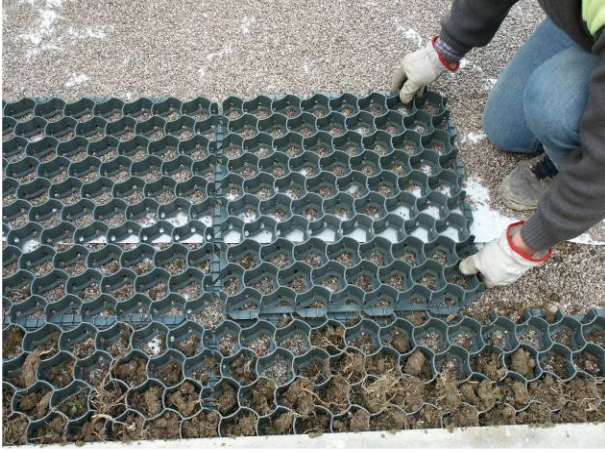
Şek.1 Zemin hazırlığı sonrası Salvaverde montajı
