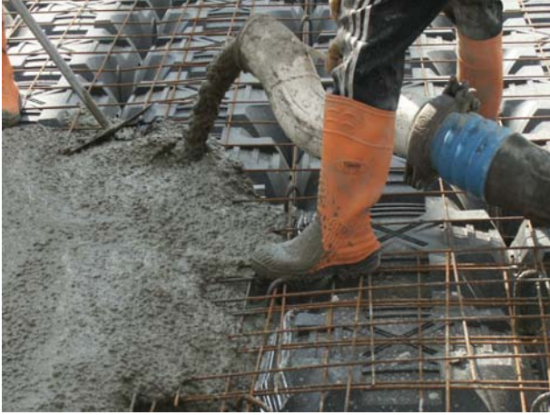
Şek.3 Beton dökümünün detayı
