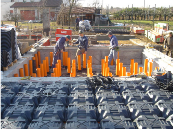
Şek.1 Yeni Elevetor'ın Montajı
