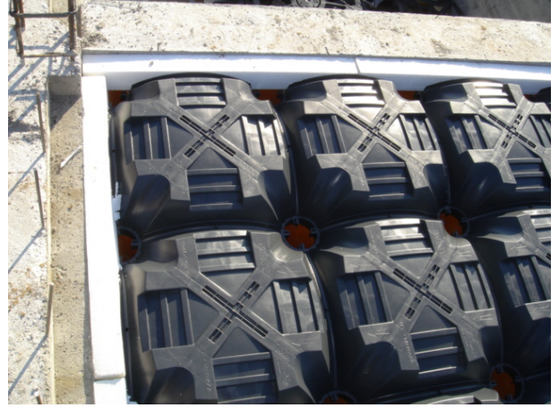
Şek.2 Polistiren kompanzasyon şeridi detayı
