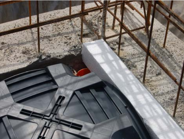
Şek.3 Polistiren şeridi ile kompanzasyon detayı
