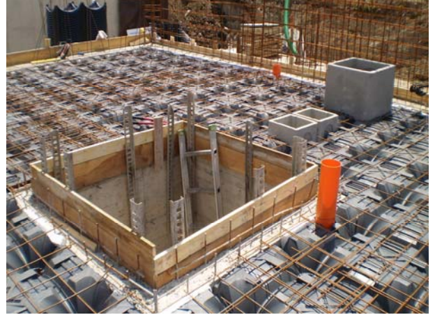
Şek.2 Asansör şaftı detayı
