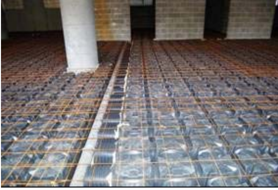
Şek.1 Geoblock ile tesisat geçişi detayı
