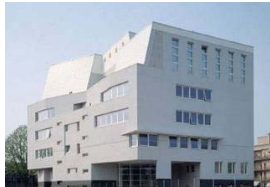
Şek.4 Yapının dışarıdan görünümü
