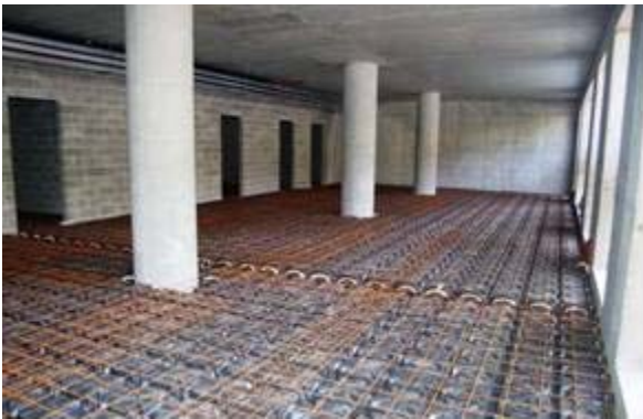
Şek.3 Beton dökümüne hazır havalandırılmalı temelin görüntüsü
