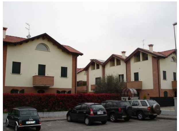
Şek.4 Binanın dışarıdan görünümü
