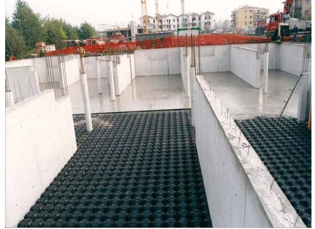
Şek.2 Kısmi olarak uygulanmış beton dökümü
