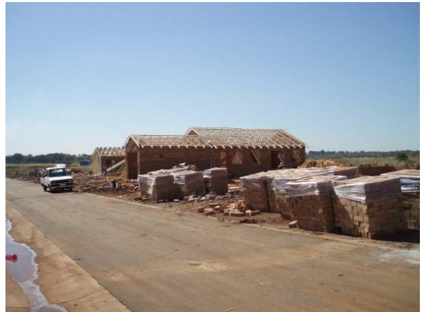
Şek.4 İnşa halindeki evin görünüşü
