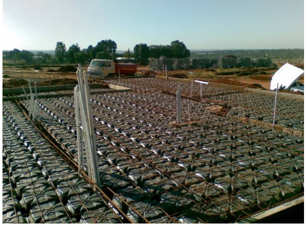
Şek.2 Monte edilmiş ve beton dökümü için hazır Modulo
