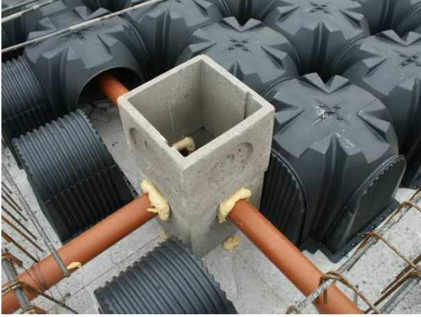
Şek.1 Kontrol menhölü ve Geoblock detayı
