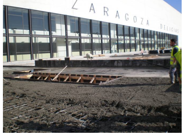
Şek.2 Beton dökümü
