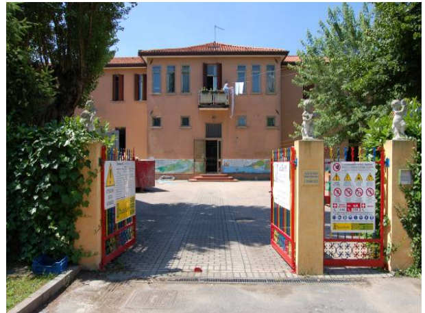
Şek.4 Binanın dışarıdan görünümü
