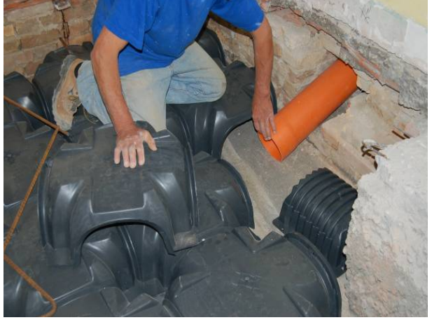
Şek.2 Havalandırma borularının detayı
