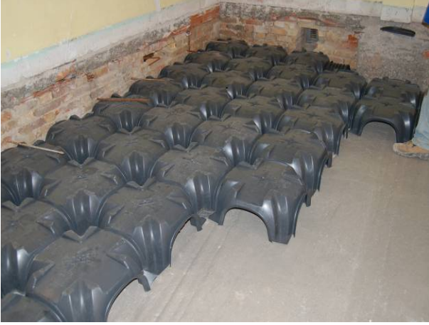
Şek.1 Modulo'nun montajı
