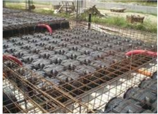
Şek.2 Tesisat montajı
