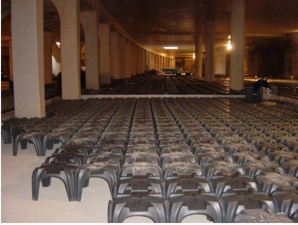
Şek.1 Modulo'nun montajı
