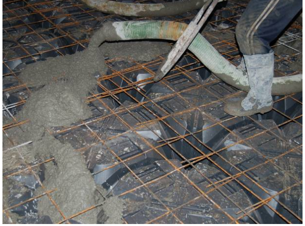
Şek.2 Beton dökümü
