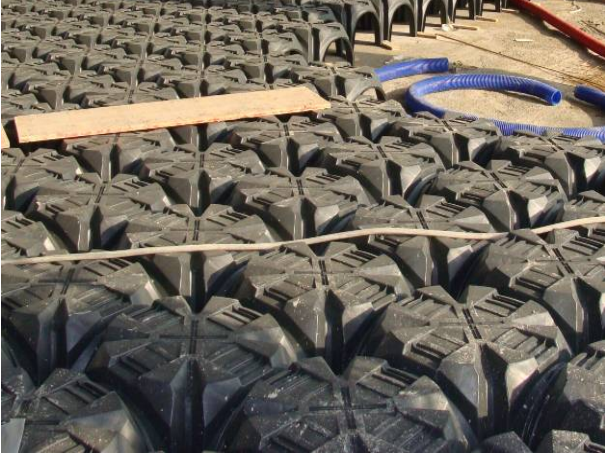
Şek.1 Modulo'nun montajı
