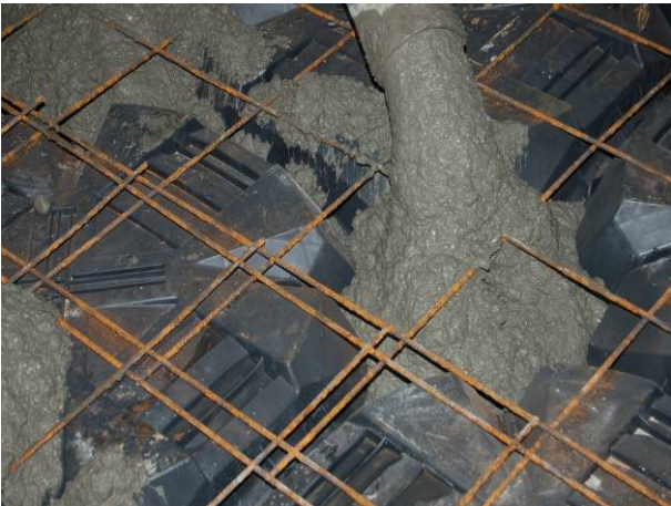
Şek.3 İlk beton dökümü aşaması
