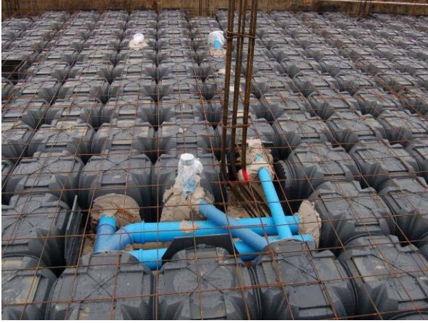
Şek.1 Tesisat detayı ile birlikte Modulo montajı
