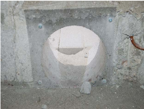
Şek.3 Haşerelere karşı koruma için metal ızgaralı havalandırma deliği detayı
