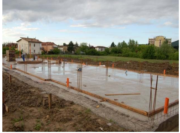
Şek.2 Havalandırma boruları ile birlikte bitmiş plak
