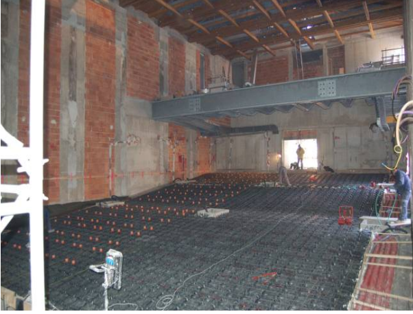
Şek.1 Modulo'nun montajı
