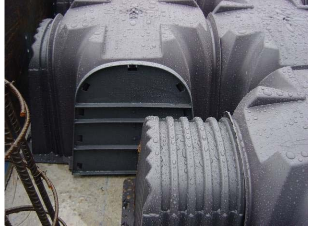
Şek.2 Geoblock detayı
