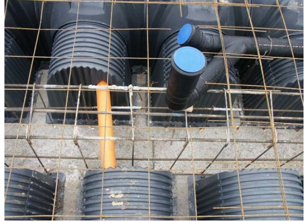
Şek.2 Havalandırma bağlantısının detayı
