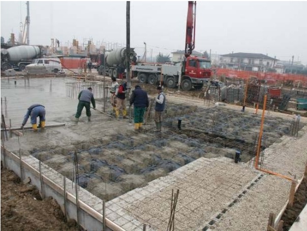
Şek.3 İlk beton döküm aşaması
