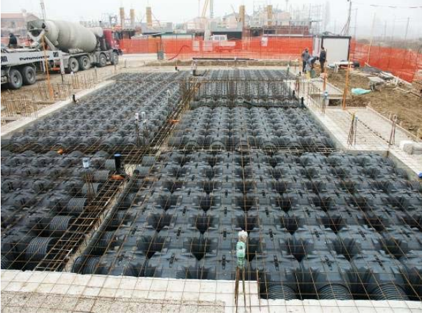
Şek.1 Modulo'nun montajı
