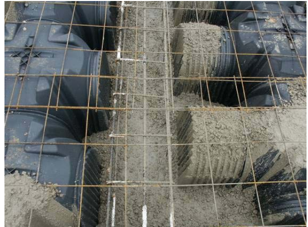
Şek.4 Tek parça temel dökümü detayı – zemin kirişi
