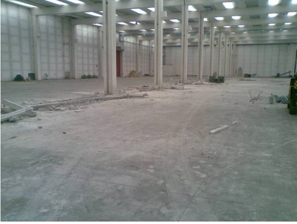
Şek.1 Mevcut depo zemini
