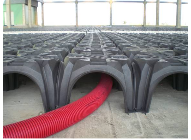
Şek.2 Modulo ve boruların montajı
