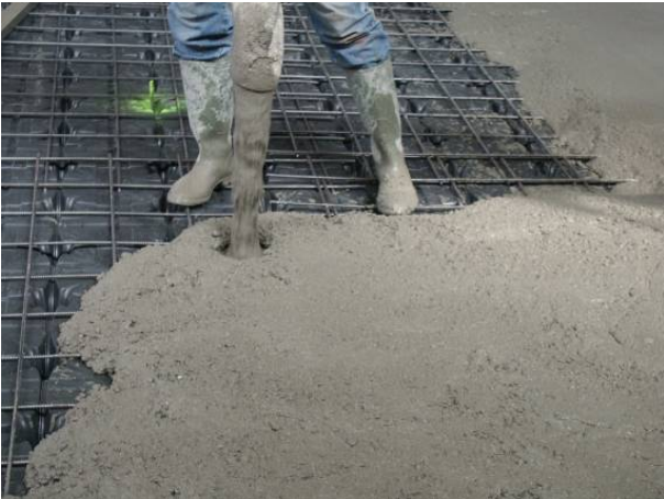
Şek.3 Devam eden beton dökümü
