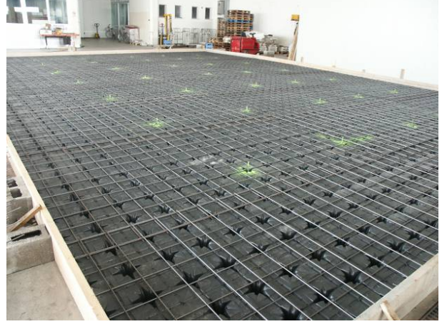
Şek.2 Beton dökümü için hazır sistem
