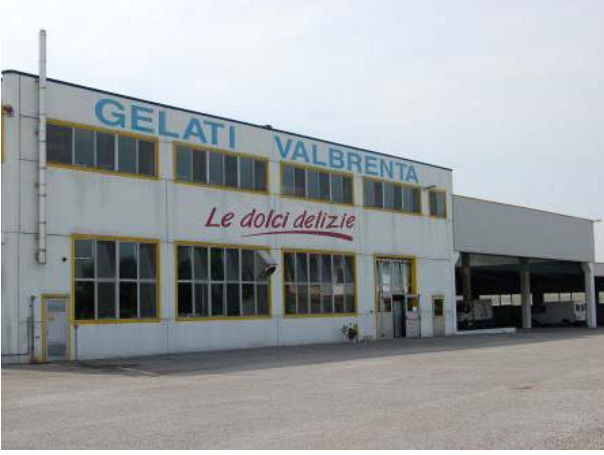
Şek.1 Binanın dışarıdan görünümü
