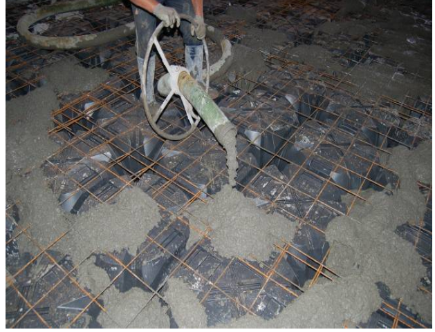
Şek.2 İlk beton dökümü aşaması
