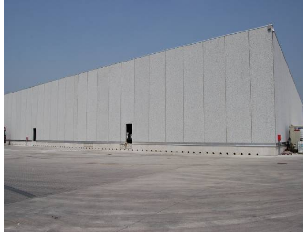
Şek.4 Binanın dışarıdan görünümü
