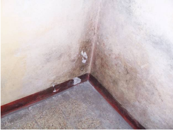
Şek.1 Onarım öncesi durum
