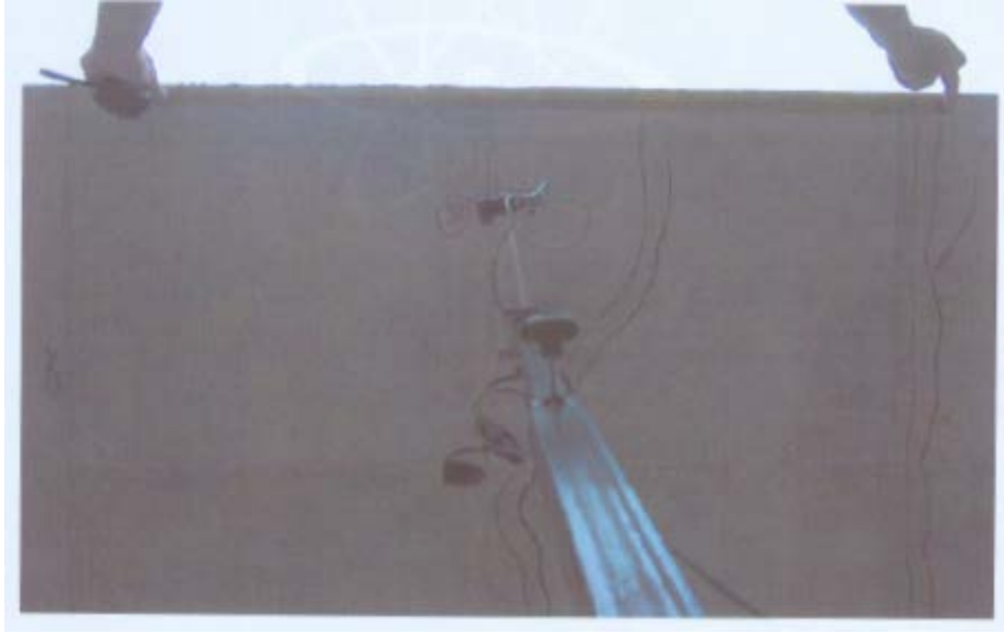
Zemin alt tabanındaki çatlaklar
