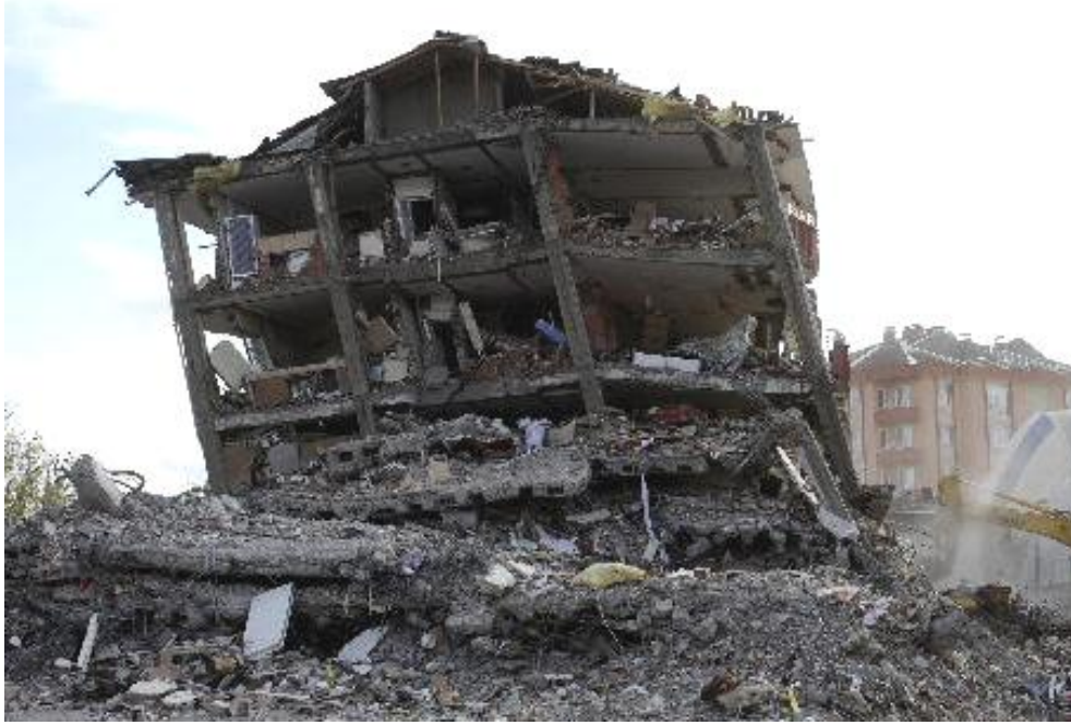
Şekil 1. Erçiş ilçesinde ağır hasar görmüş/göçmüş asmolen yapılar
