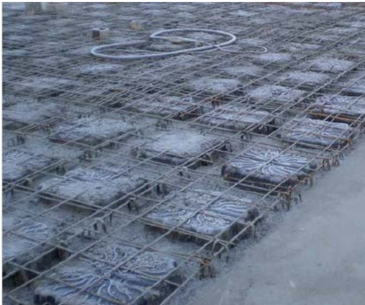
Şekil 1.8 : Birinci aşama beton dökümü.
