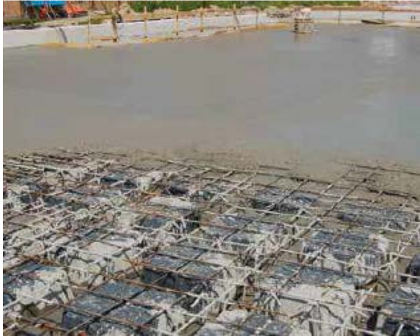
Şekil 1.9 : Betonu dökülmüş Yeni Nautilus® kör kalıpları ile oluşturulmuş döşeme
