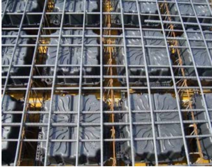
Őekil 1.7 :  st hasır donatısı yerleřimi ve beton d k m  i in hazır hale getirilmesi
