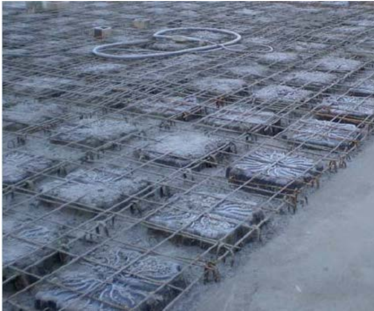
Şekil 1.8 : Birinci aşama beton dökümü.
