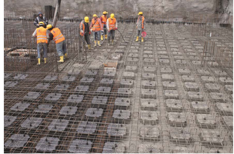
Resim 2 - Nautilus beton dökümü
