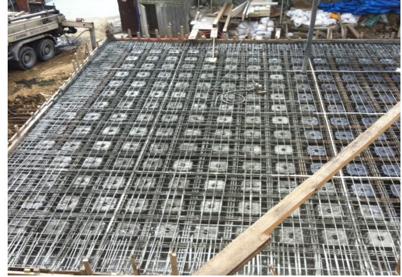
Resim 4 - Nautilus beton dökümü
