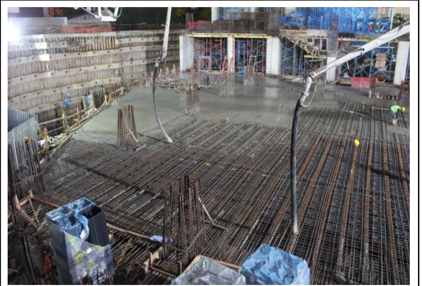
Resim 14 - Nautilus beton dökümü
