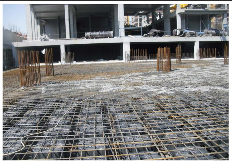
Resim 10 - Nautilus beton dökümü
