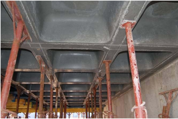
Şek.4 Kalıp söküldükten sonra betonarme döşemenin görünümü
