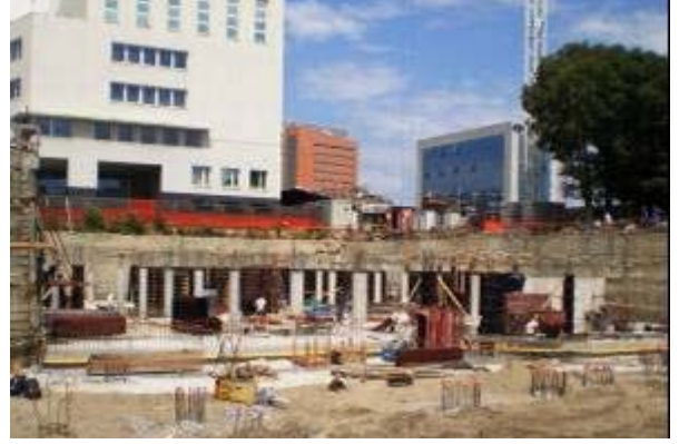
Şek.2 Uygulama sahasının genel görünümü
