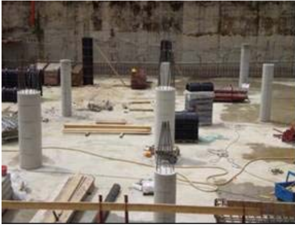
Şek.3 Kalıp sökümü sonrası
