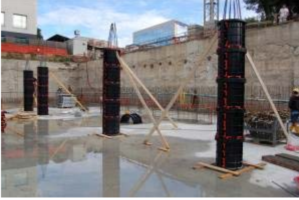
Şek.1 Kolon kalıbı – zemin bağlantısı
