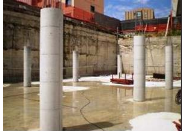
Şek.4 Betonarme kolonların yüzey bitişleri
