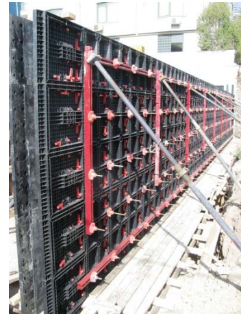
Şek.4 Döküme hazır duvar kalıbı
