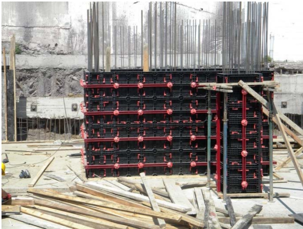
Şek.3 Geopanel Star ve Geopanel kalıp sistemleri
