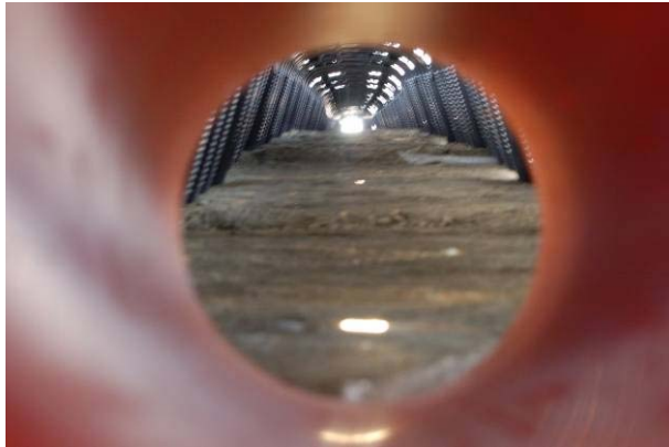
Şek.4 Drening tünelinin iç görünümü
