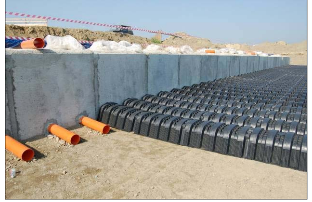
Şek.3 Su havzasının sel suyu toplama sistemi ile bağlantısı
